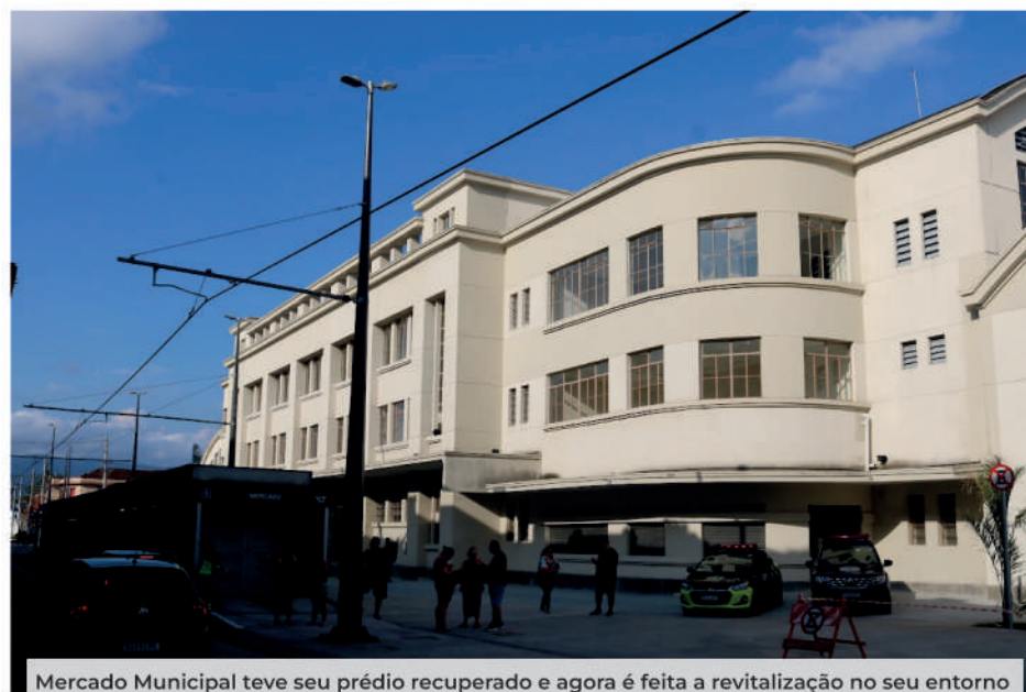
Mercado Municipal teve seu prédio recuperado e agora é feita a revitalização no seu entorno
