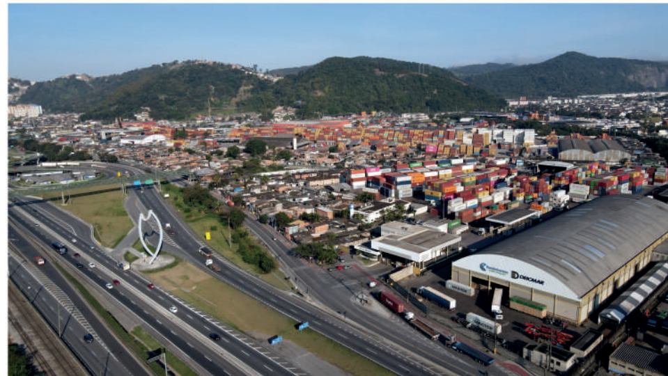
São 100 mil m 2 de instalações retroportuárias alfandegadas, na 'entrada' de Santos
