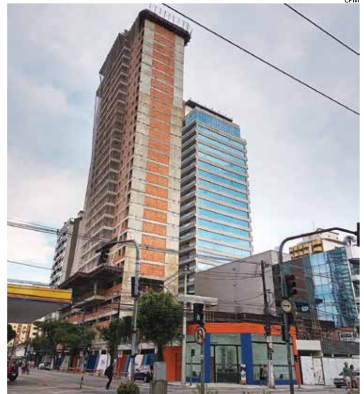
Obras do Castell Di Indaiá estão em estado avançado, na Avenida Ana Costa
