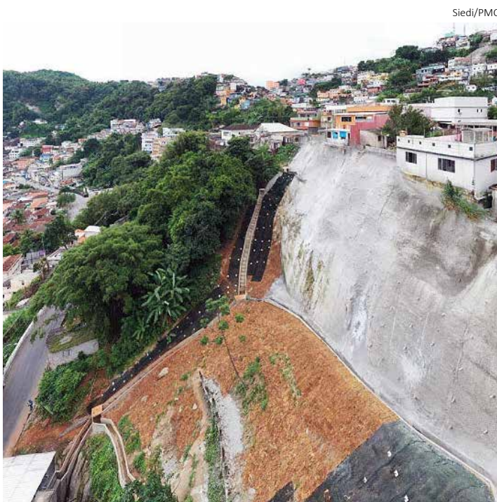
Frente de trabalho atuou na encosta do Morro São Bento
