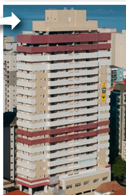
FASE FINAL DE CONSTRUÇÃO
