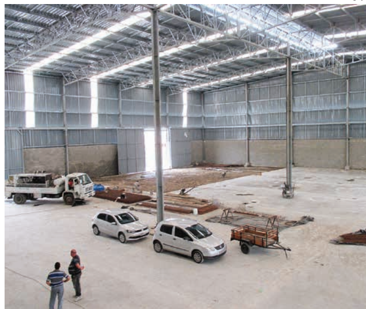
Galpão em final de construção permitirá que cliente agilize a expansão de seus negócios
