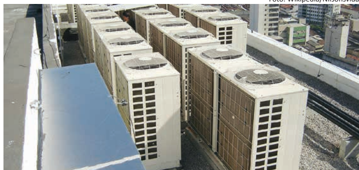
Instalação de equipamentos Variable Refrigerant Flow (VRF) no Rio de Janeiro
