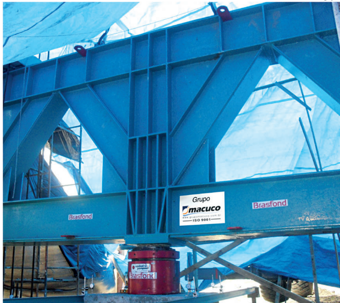
Teste de carga confirma a completa segurança das estruturas
